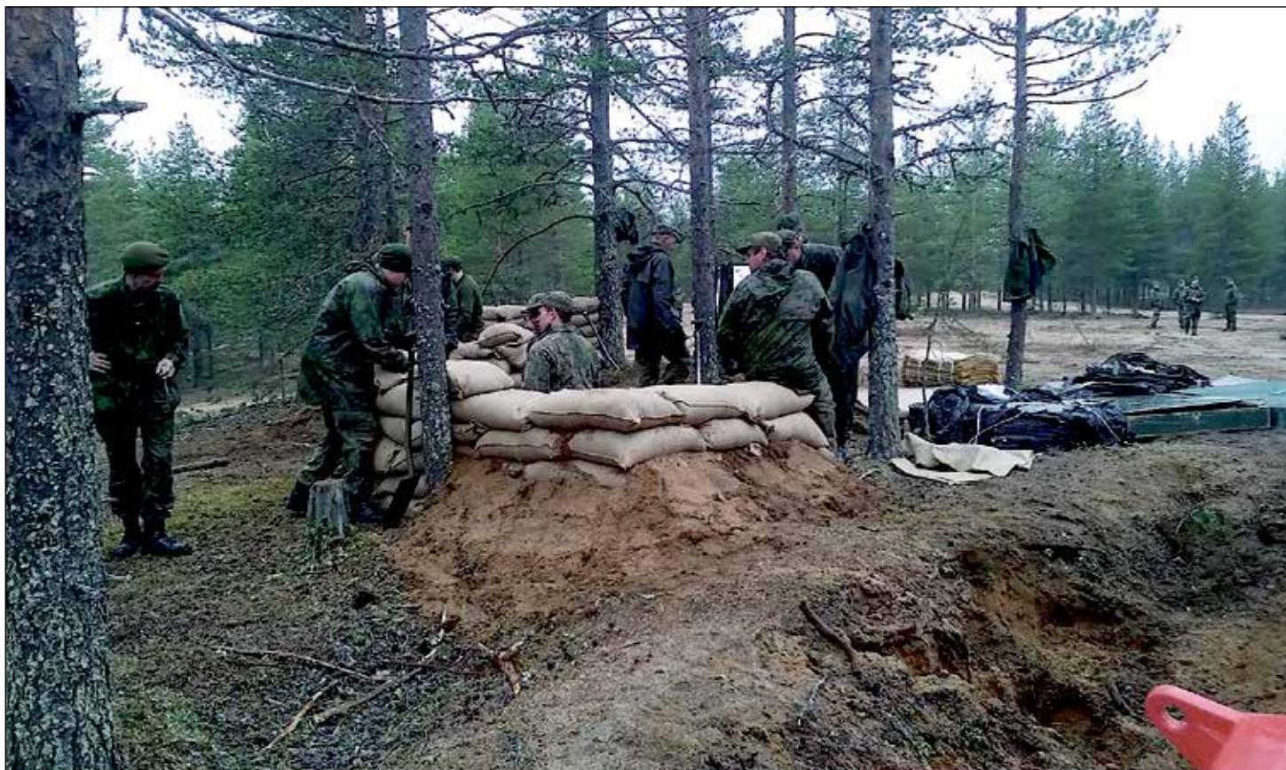
Poterohan syntyy kaivamalla ja hiekkasäkeistä latomalla.
