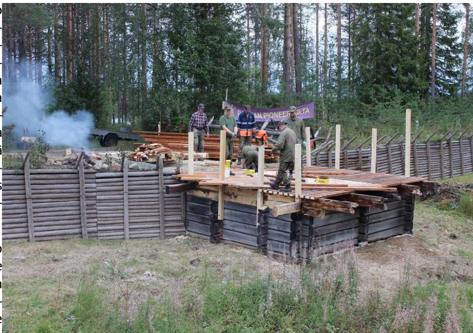
Kannen laudoitustyö käynnissä, kuvassa näkyvät tukiparrujen päät räjäytyksen jäljeltä
