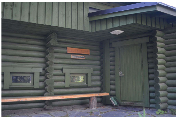
Kiltä rakensi talkootyönä 1994 ylemmässä kuvassa olevan Kiltakorsun ja pari vuotta myöhemmin alemmassa kuvassa olevan Kiltasaunan. Kuvat: Lukas Salminen
