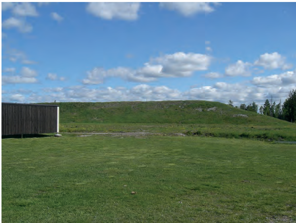
Kuva 9.16. 15 metriä korkea meluvalli Sipoon SSG:n haulikkoradalla.
