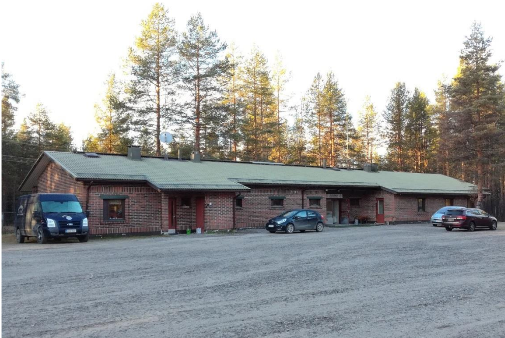
Toramon Reserviläistalo, Rajavartiolaitoksen entinen sotilaskoti ja esikuntarakennus, ostettiin Lapin reserviläispiirien toimintakeskukseksi Rovaniemen kaupungilta vuonna 2015. Tätä ennen tiloissa oltiin oltu vuokralla jo jonkin aikaa.
