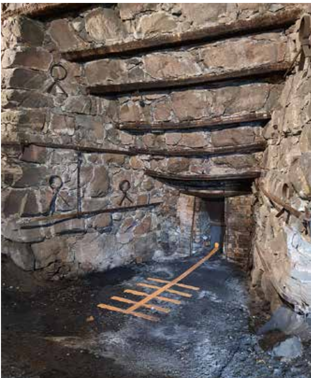
Piipun pesän pohjalle valui n. 1400 asteinen rauta, joka juoksetettiin muotteihin.
